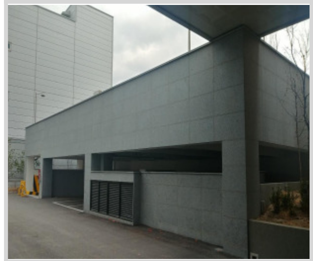
본건 전경(1층 주차장 부분)
